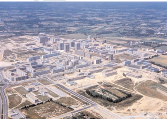
Le quartier de Villejean en construction (1966)
