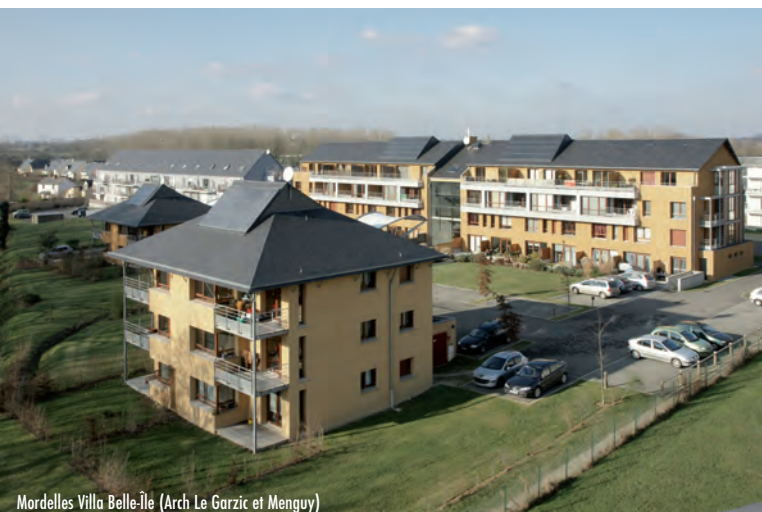
Mardelles Villa Belle-Île (Arch Le Garzic et Menguy)
